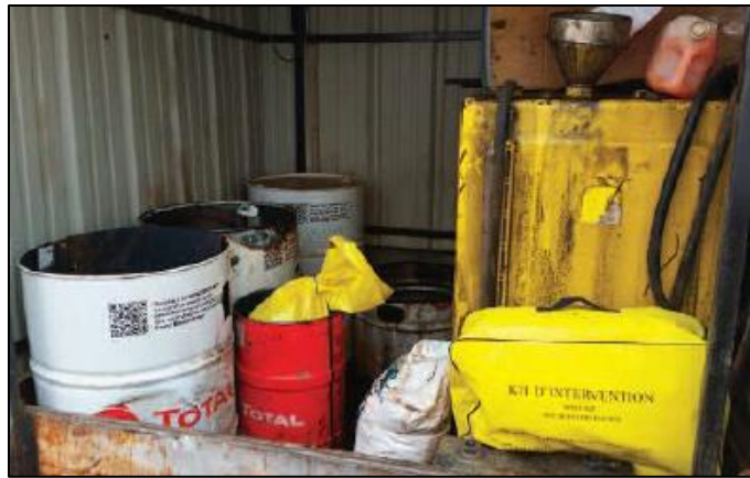
Figure 60 : Exemple d'aire de stockage pour matériaux polluants (Guide technique "Protection des milieux aquatiques en phase chantier", AFB, 2018)
