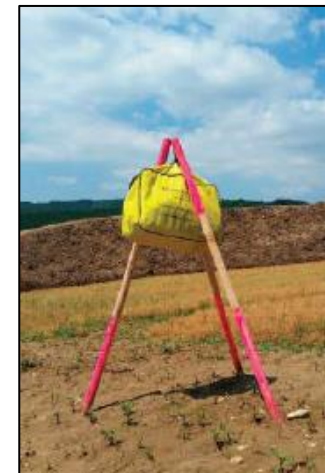
Figure 61 : Exemple de kit anti-pollution isolé du sol (Guide technique "Protection des milieux aquatiques en phase chantier", AFB, 2018)
